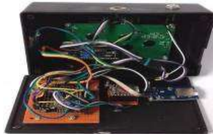
Gambar 21. Pemasangan semua kabel komponen
