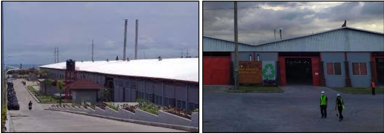
Gambar 4. Penampakan Cerobong Asap TPST Desa Kesiman Kertalangu
