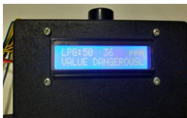
Gambar 17. Pengujian Sensor MQ2 Kondisi Berbahaya
