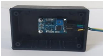
Gambar 9. Pemasangan sensor gas
