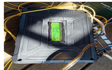
Gambar 4.1 Pemasangan peralatan Hybrid PLN dan PLTS ke dalam kotak. (sumber: Penulis 2021)
