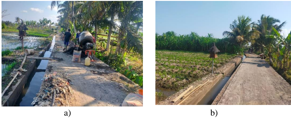
Gambar 2. a) Proses pengecoran Cast in-situ, b) Saluran irigasi hasil pengecoran Sumber : Dokumen Pribadi 2023
